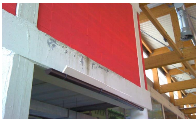
Infiltrazioni locali piano primo
