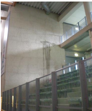
Palaghiaccio - pareti danneggiate a seguito delle infiltrazioni
