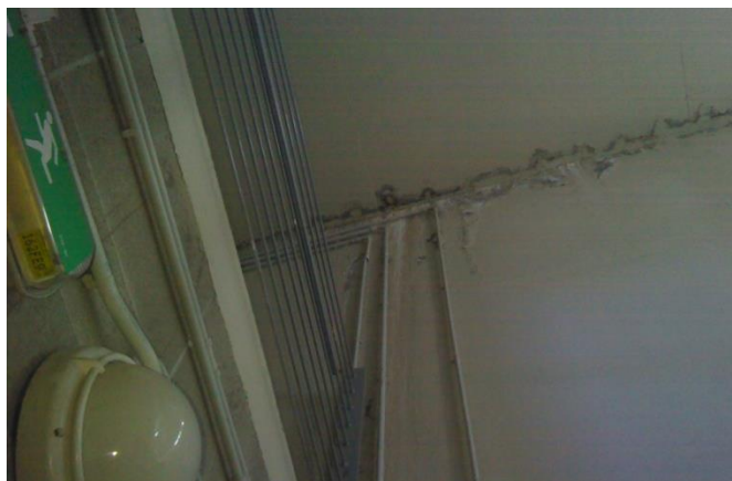
Infiltrazioni piano terreno (area pista)
