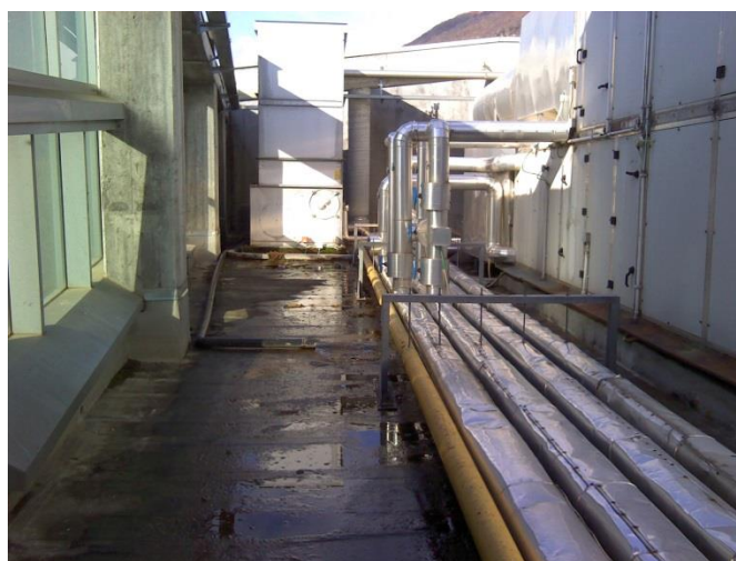
Infiltrazioni presenti in corrispondenza del piano copertura (coronamento)
