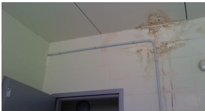
Infiltrazioni presenti in corrispondenza del piano copertura (coronamento)
