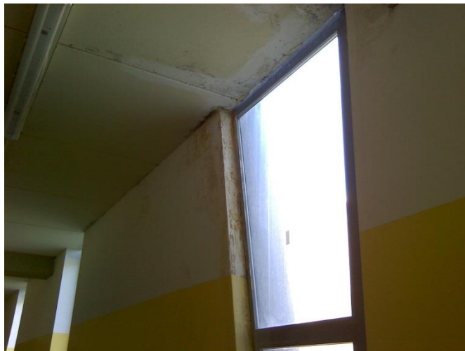
Infiltrazioni locali piano primo
