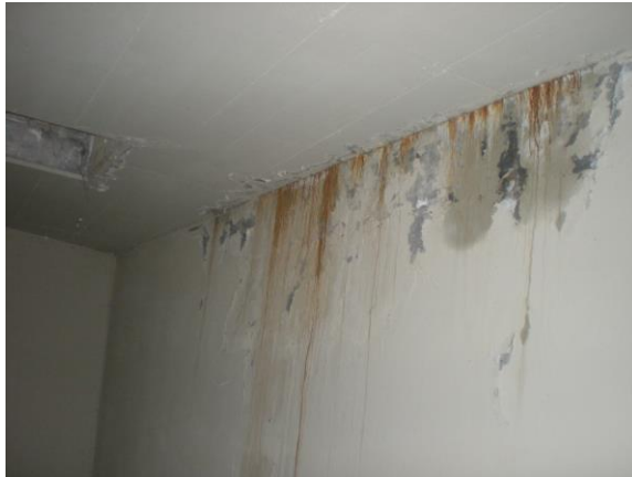
Palaghiaccio - pareti danneggiate a seguito delle infiltrazioni
