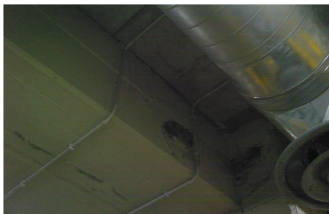
Infiltrazioni piano interrato
