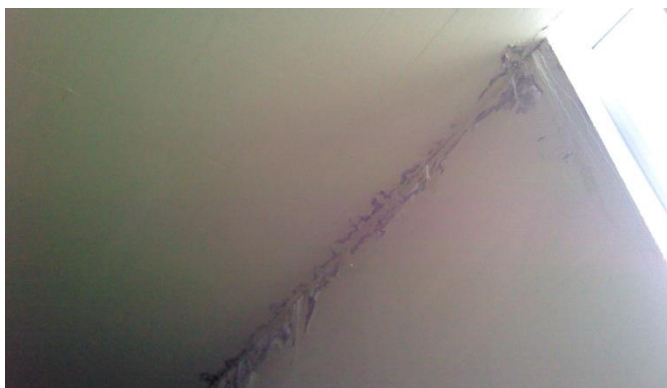
Infiltrazioni blocco scale
