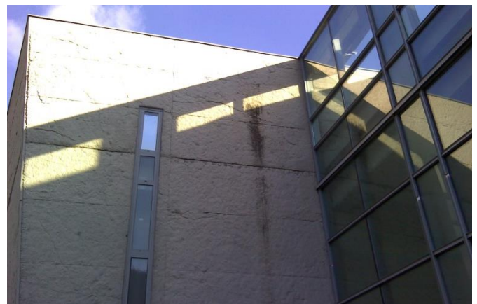
Infiltrazioni presenti in corrispondenza delle facciate esterne del Palaghiaccio
