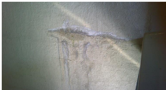
Infiltrazioni presenti in corrispondenza del piano copertura (coronamento)
