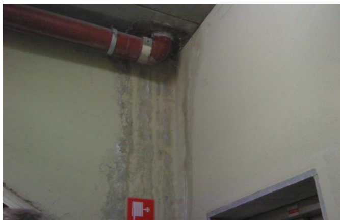
Infiltrazioni piano interrato
