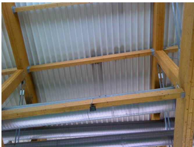
Infiltrazioni in corrispondenza della copertura della pista
