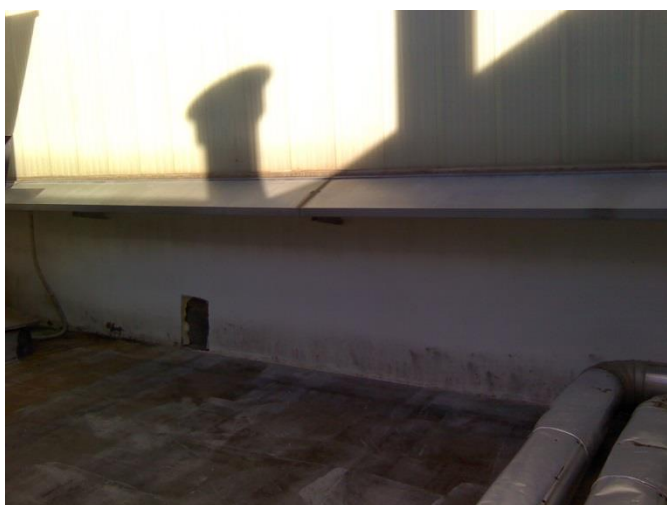
Infiltrazioni presenti in corrispondenza del piano copertura (coronamento)
